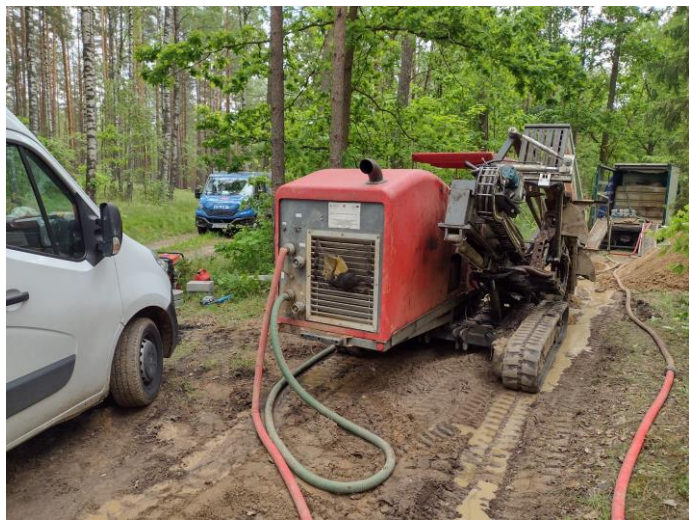
Trwająca budowa sieci kanalizacji sanitarnej w Jeleniowie
